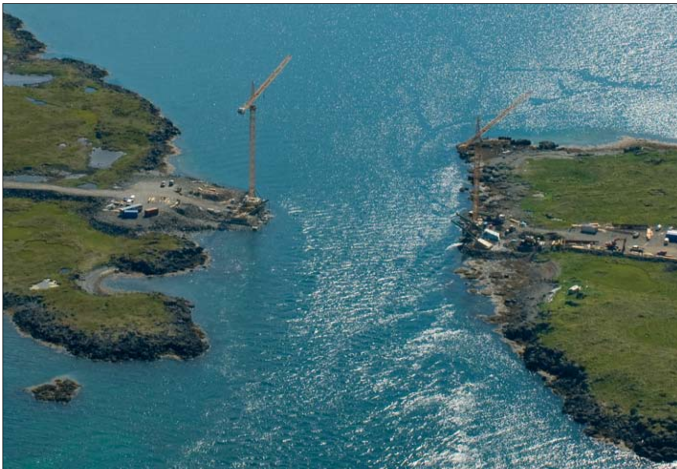
Nýr Djúpvegur yfir Mjóafjörð í Ísafjarðardjúpi 25. júní 2008. Vinnusvæði brúasmíða. Verktaki er KNH ehf. og Vestfirskir verktakar ehf. Ljósmynd: Mats Wibe Lund.
